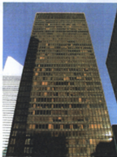
Seagram Building, New York. (Architectes : Mies van der Rohe et Philip Johnson, 1954-1958)
